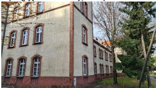
Fot. Budynki mieszkalne powojenne wymagające modernizacji, ul. Młyńska
