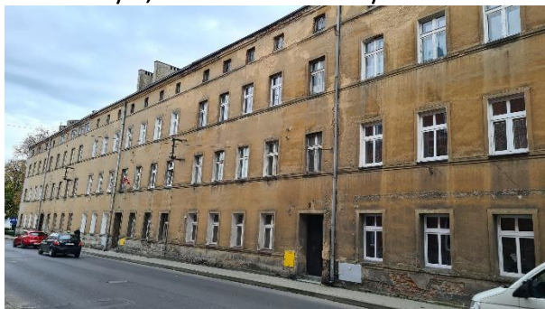
Fot. Budynek komunalny w złym stanie technicznym, ul. 56 Pułku Piechoty 2-4-6
