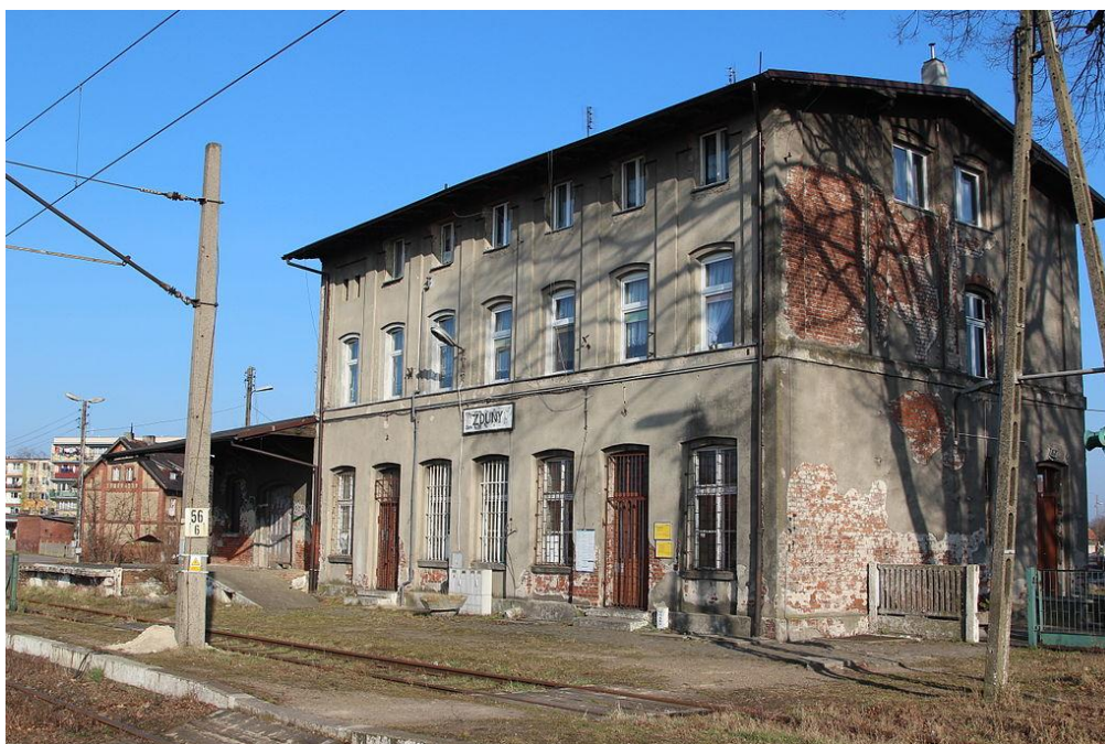
Fotografia 7 Stacja kolejowa w Zdunach
