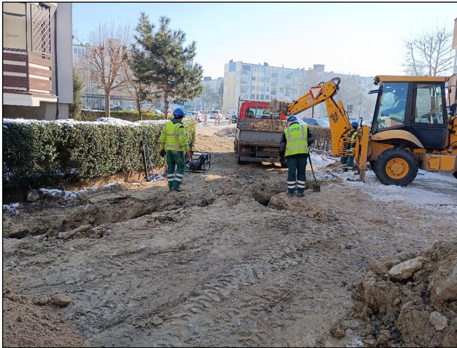
Budowa sieci wodociągowej w rejonie os. Szarych Szeregów
